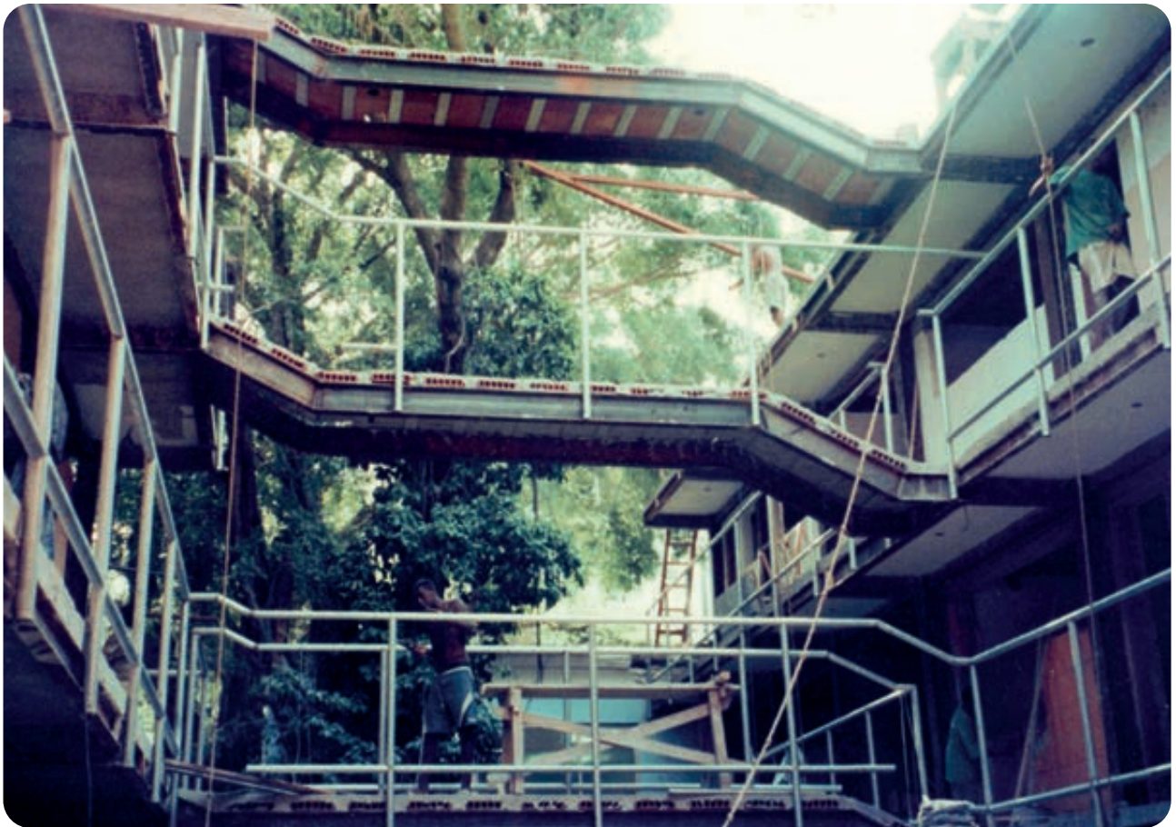
CONSTRUÇÃO DAS PASSARELAS NAS OBRAS PARA A FUSÃO, NA VIRADA DE 2000 PARA 2001.
